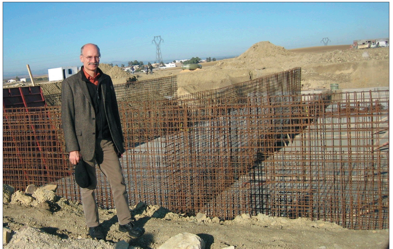
Udo Bäuerle auf der Baustelle in Tunesien: Die neue 50 Millionen Euro teure Kläranlage wird für die Abwasserentsorgung der tunesischen Hauptstadt benötigt. (Fotos: privat)
